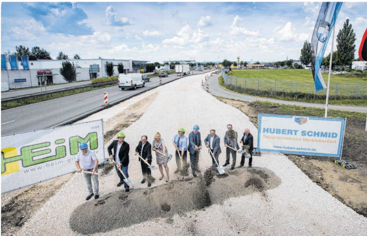
Alle Spaten fliegen hoch! Gestern Mittag ging es symbolisch los mit dem Kreuzungsumbau an der Europastraße.
