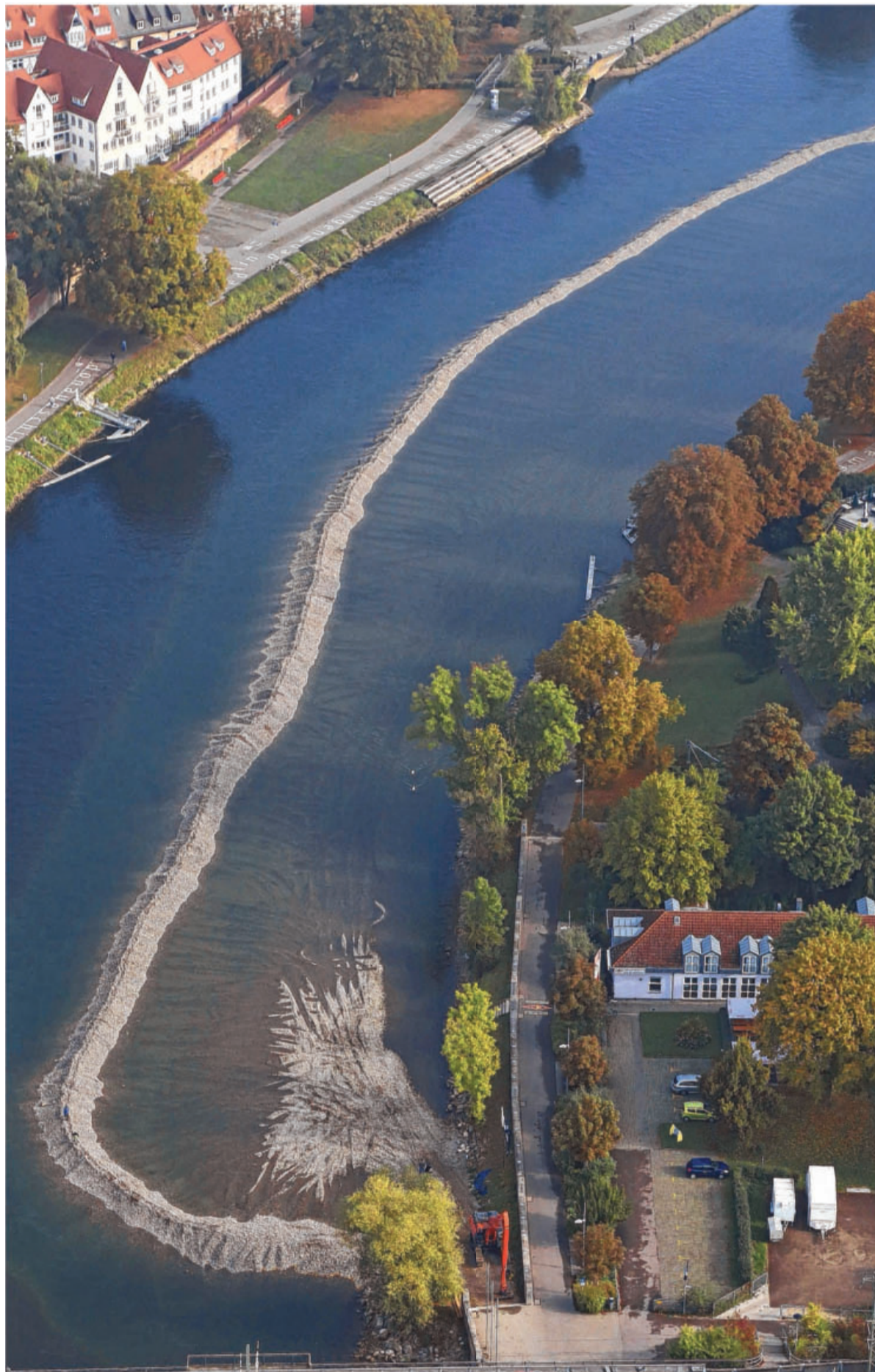
350 Meter lang ist die künstliche Kiesstraße, auf der Lastwagen in zwei Wochen das Material wegfahren, das aus dem Flussbett links und rechts davon rausgebagert wird. Foto: Siegfried Geyer
